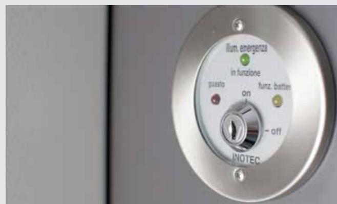
Le centrali CLS sono dotate di 3 contatti relè privi di potenziale max. 24V DC 1A, per segnalazione con pannelli MTB o con sistemi esterni dello stato di funzionamento (In funzionamento, Guasto, Funzionamento in batteria). È presente un contatto relè opzionale per programmazione libera. In dotazione vien dato un ingresso FS+ FS-, normalmente chiuso, la cui apertura, anche da attuatore remoto, permette di attivare una delle due funzioni programmabili:
